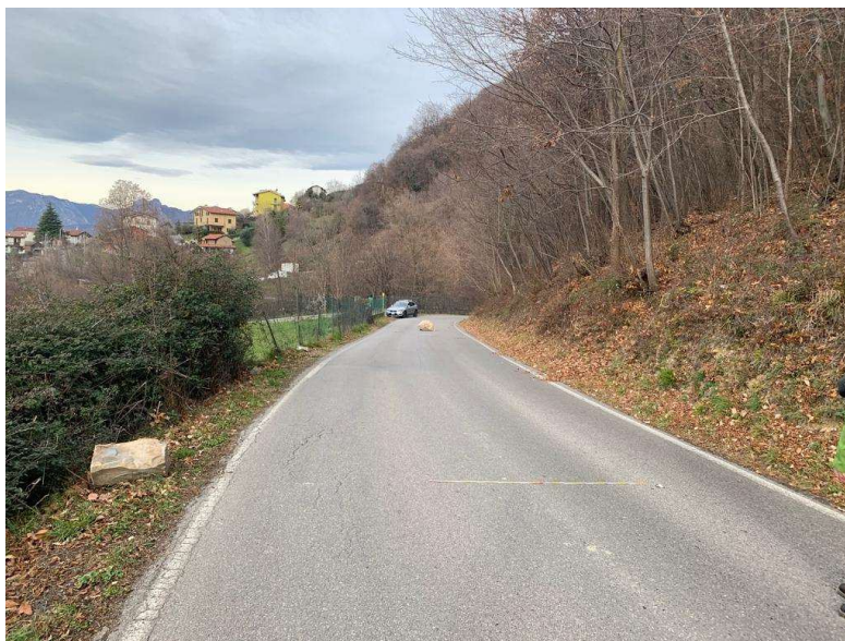
Masso 3 ritrovato a bordo strada, è visibile il punto d'impatto e la traccia di caduta
